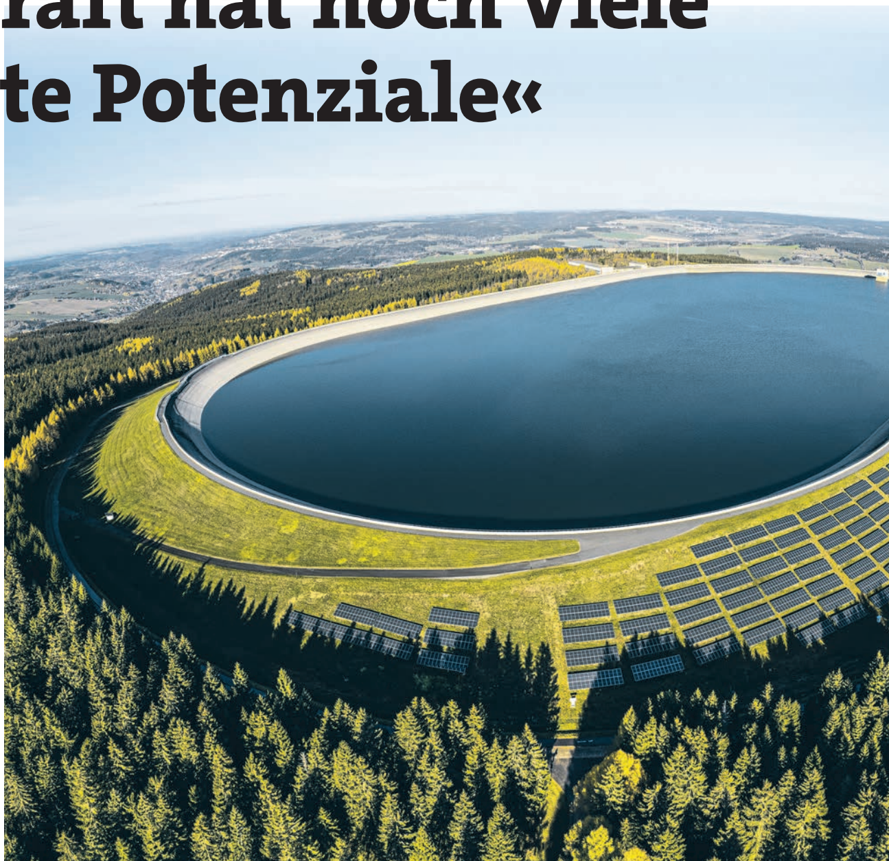
Wasserkraft als erneuerbare Energie – das Oberbecken des Pumpspeicherkraftwerks Markersbach, Sachsen
